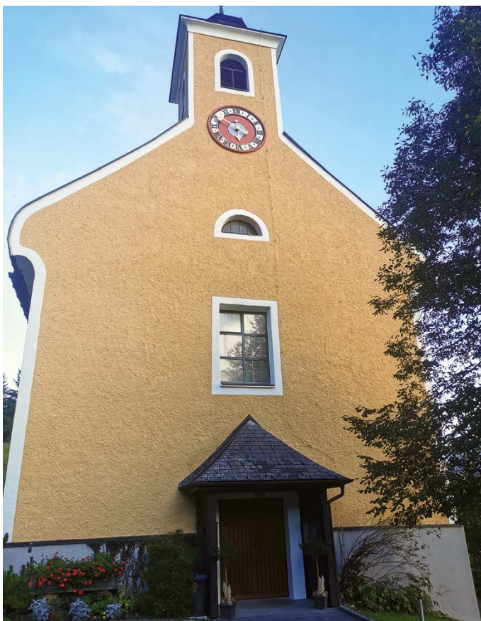
Geht man auf das Gotteshaus in St. Martin zu, so erstrahlt die Westfassade nun wieder in neuem Glanz. Die Malerei Frangu hat die Renovierung durchgeführt. Durch großzügige Spenden konnte der Betrag von € 13.352,51 aufgebracht werden. Herzlichen Dank an alle Spender!
