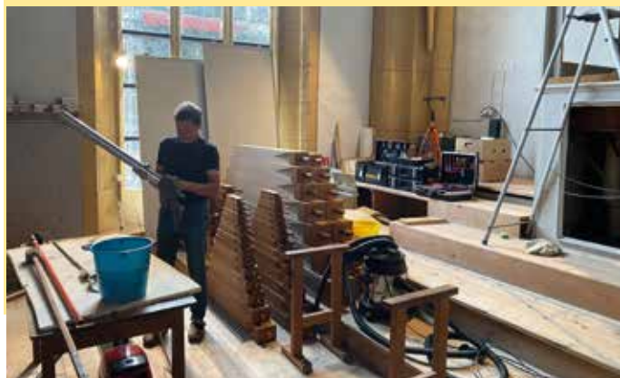
Organist G. Hemedinger hilft bei der Sanierung
